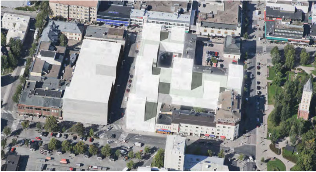
Kuva 81 Tutkielma Oksasenkadun, Sammonkadun, Valtakadun ja Kauppakadun välisen korttelin lisärakentamisesta. Kaaviomainen luonnos ydinkeskustan täydennysrakentamisen periaatteista
