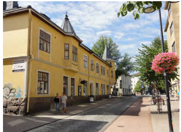
Kuva 20 Lappeenrannan ydinkeskustaa, näkymä Valtakadulta, etualalla Kinnusen talo. Kuva: Lauri Putkonen.
