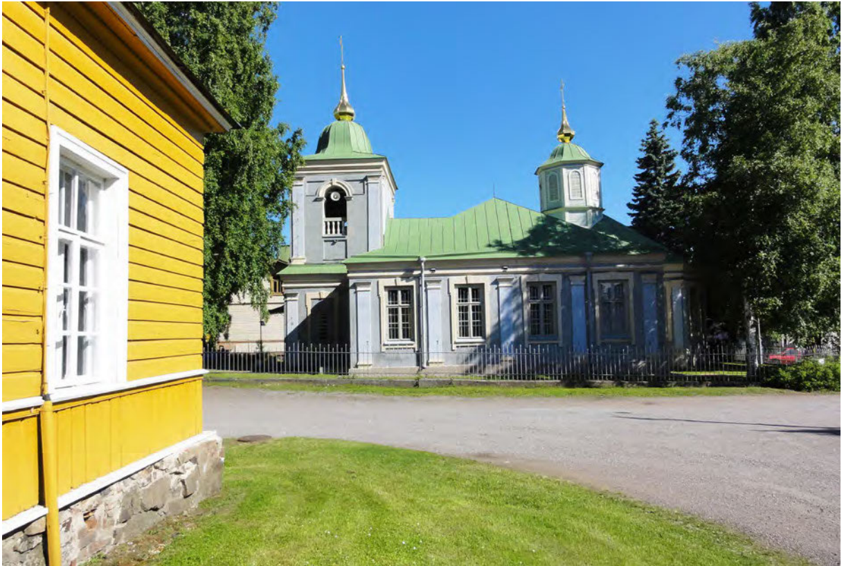
Kuva 78 Linnoituksen kulttuurihistoriallisesti arvokasta rakennuskantaa, taka-alalla ortodoksinen kirkko. Kuva: Lauri Putkonen.
