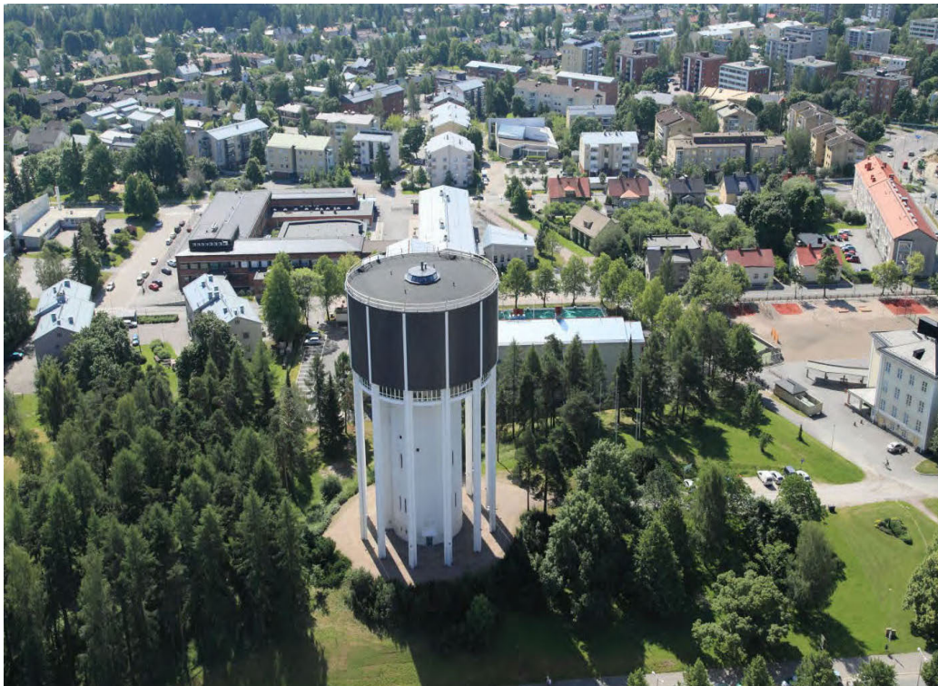
Kuva 90 Lappeenrannan kulttuurihistoriallisesti merkittävä vesitorni sijaitsee Taikinamäen kaupunginosassa. Kuva: Lappeenrannan kaupunki, kiinteistö- ja mittastoimi 2014. Kuvaaja Raimo Suomela.
