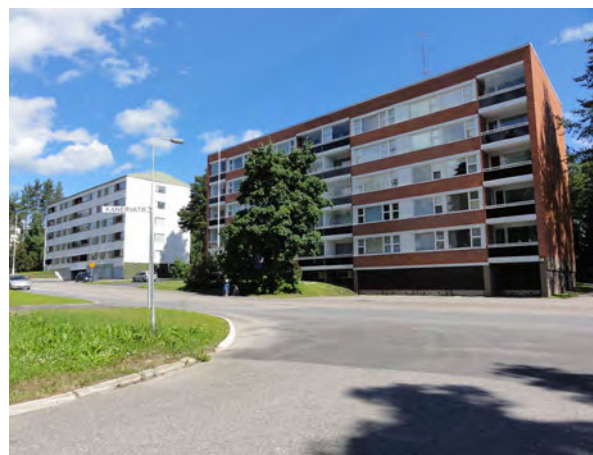
Kuva 16 Asuinkerrostaloja Voisalmessa, näkymä Kanervatien ja Saratien risteyksestä. Kuva: Lauri Putkonen.
