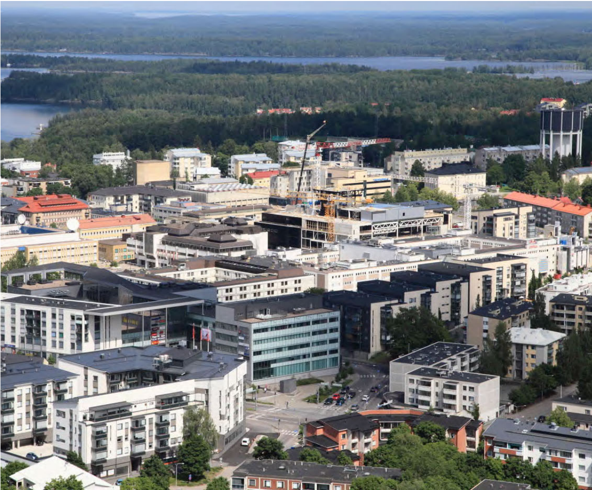
Kuva 77 Lappeenrannan ydinkeskustassa kaupunkikuva on ollut viime vuosina nopeassa muutoksessa. Kuva: © Lappeenrannan kaupunki, kiinteistö- ja mittauslaitos 2014. Kuvaaja Raimo Suomela.
